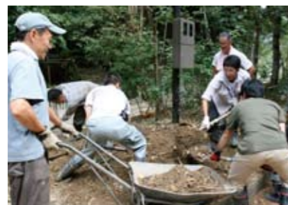
水害からの復旧作業 2009年9月 佐用町昆虫館にて
