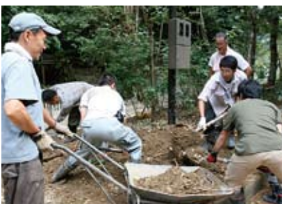
水害からの復旧作業 2009年9月 佐用町昆虫館にて
