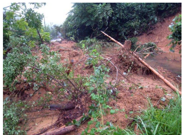
写真 16 道路に流れ出た土石、流木. 大量の土砂は溪 A に流れ込んだ. (2009. 8)
