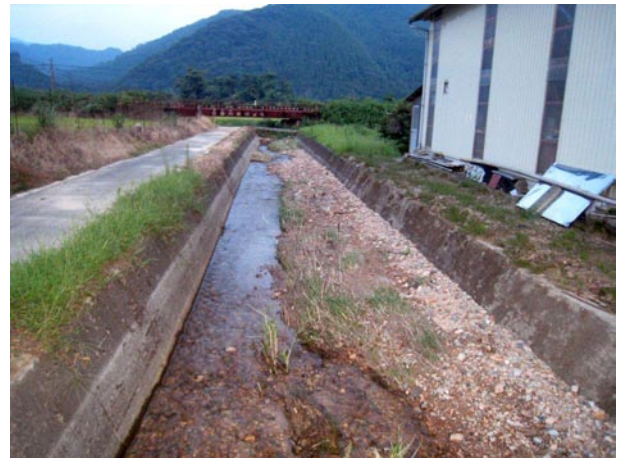
写真1 被災直後の溪流 A ②付近。(2009. 8)
