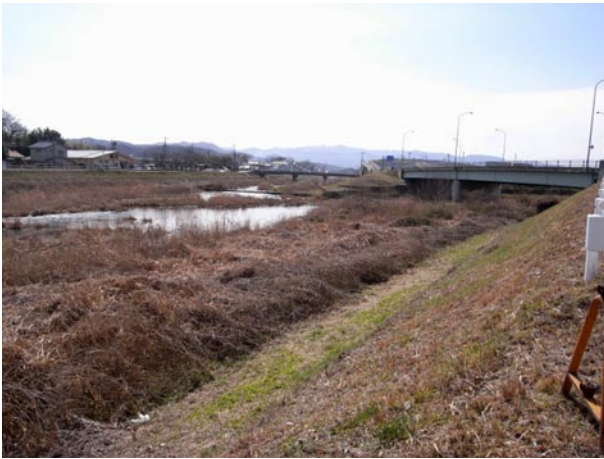
写真8 兵庫県神戸市長尾町宅原 有野川.
