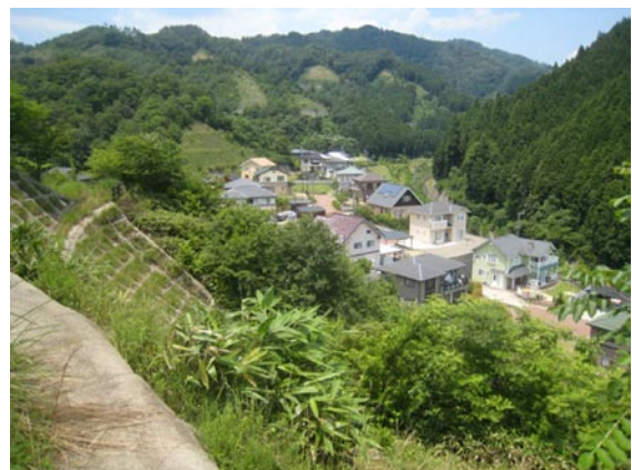
写真 14 起点から 300m 付近, 9月. 調査地全景.
