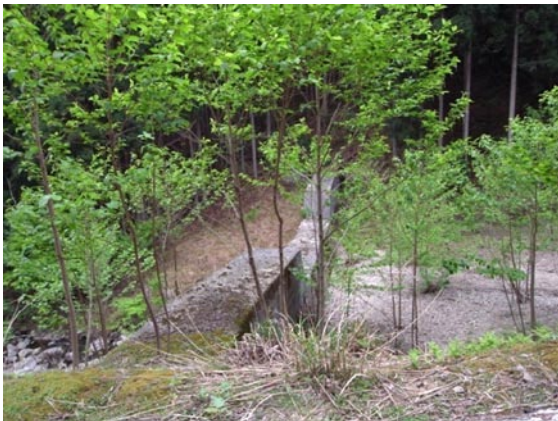
写真 11 起点から 600m 付近の谷部, 6月. オオバアサガラが生える.
