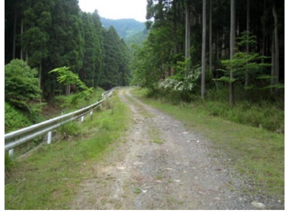
写真 10 起点から 400m 付近, 6月.
