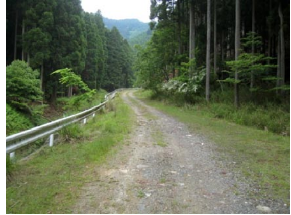
写真 10 起点から 400m 付近, 6月.
