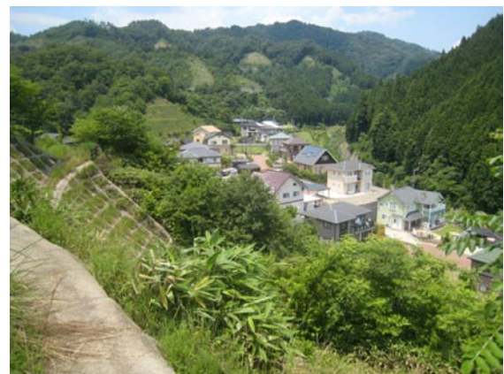
写真 14 起点から 300m 付近, 9月. 調査地全景.
