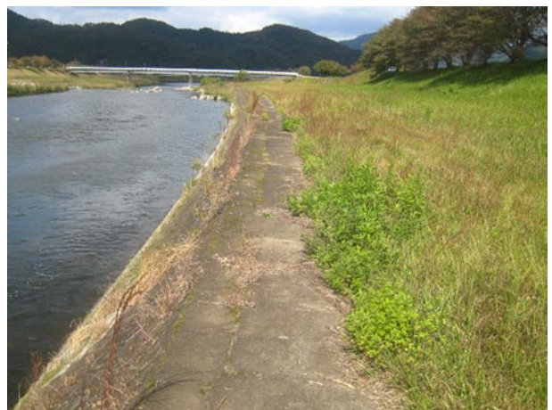
写真6 朝来市和田山町円山川河川敷の状況(2015年9月27日)。
