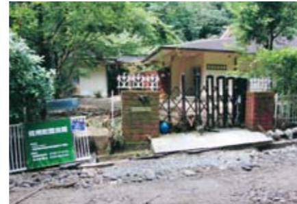
水害直後の昆虫館正面
