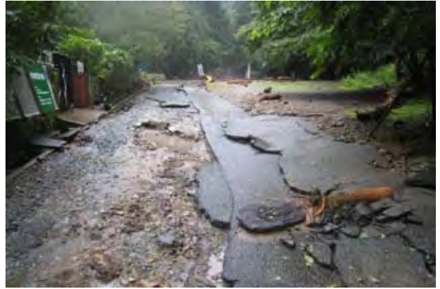
舗装がはがれた昆虫館前の町道 2009年8月10日 近藤伸一 撮影
