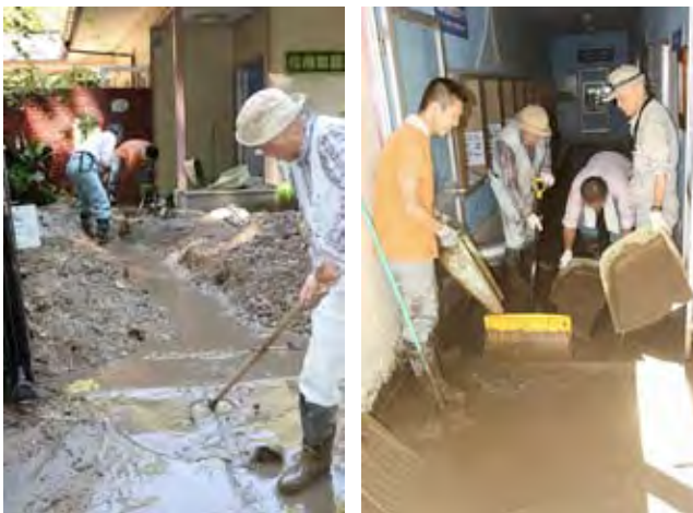
排水路の掘削、館内の排水 2009年8月15日 三木進 撮影
