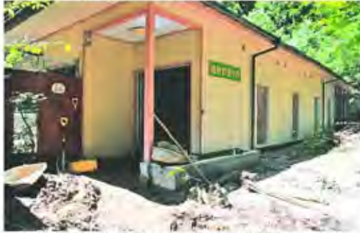
館内は浸水し、貴重な水生生物がいた池も土砂で埋まった。いずれも佐用町撮影
