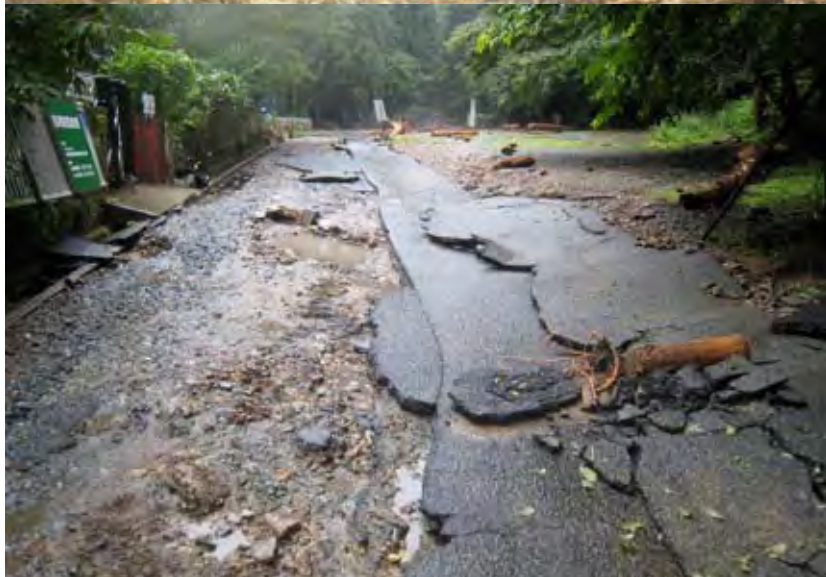
▲(写真上) 土砂に覆われた昆虫館の敷地。厚いところでは1mに達した。 (写真下) 道が川となって舗装が浮き上がった昆虫館前。
