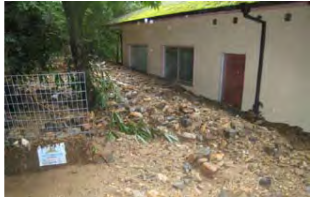
窓の高さまで土砂が堆積した館北西側。すぐ左が寺谷川 2009年8月10日 近藤伸一 撮影
