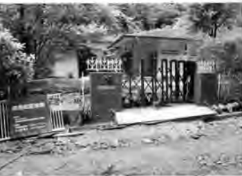
昆虫館の正面 柵は壊れ、敷地内は土砂が堆積した（高橋耕二撮影）
