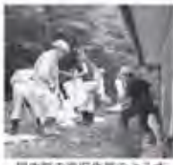
昆虫館の掘削作業の様子
