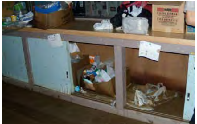
館内スタディラボの床、カウンター下の状態 2009年8月15日 中瀬大地 撮影
