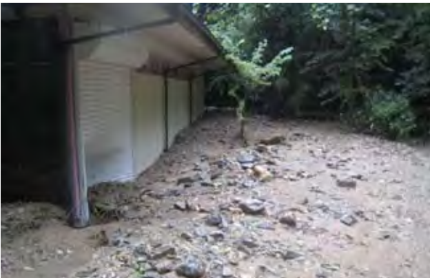
土砂が堆積した「おにぎりパクパク広場」（館北側） 2009年8月10日 近藤伸一 撮影
