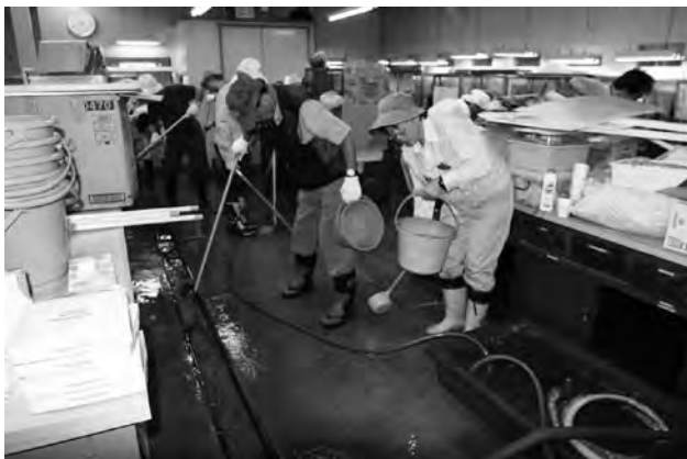
泥を洗い流して、館内を洗浄
