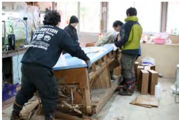
汚損した実験台の撤去 2009年11月22日 八木 剛 撮影
