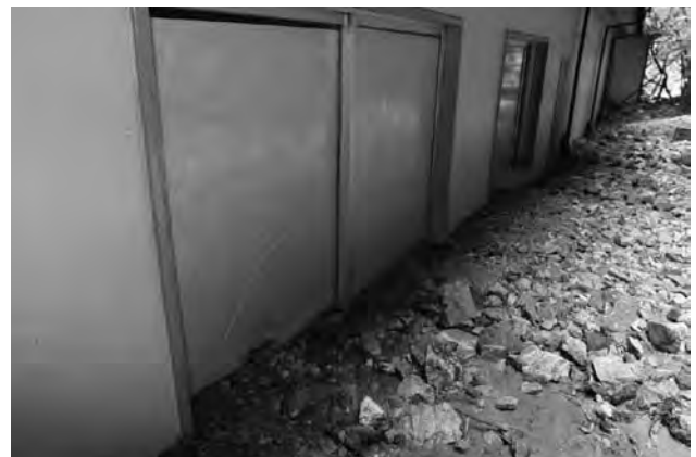
土砂が窓枠を超えた
